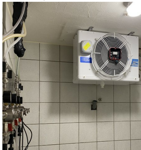
Neue Kühlanlage im Kühlhaus installiert
