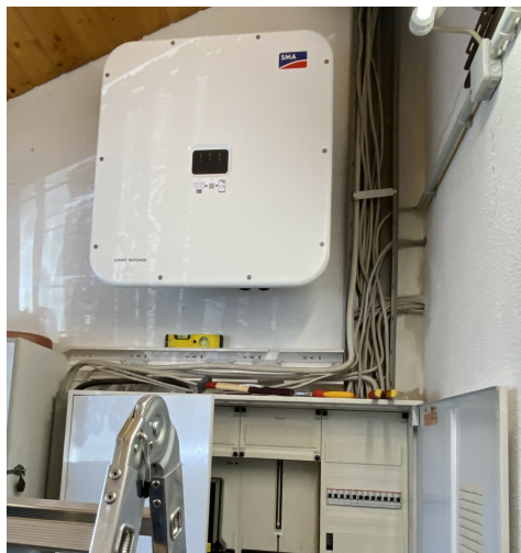
Wechselrichter PV Anlage montiert
